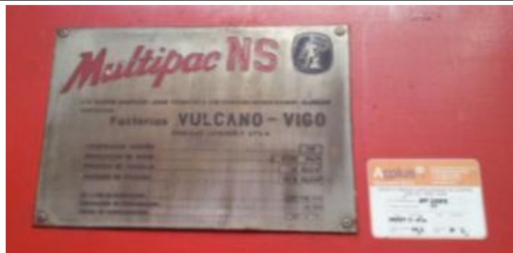
Caldera existente 4 Ton / hora - 8 bar
